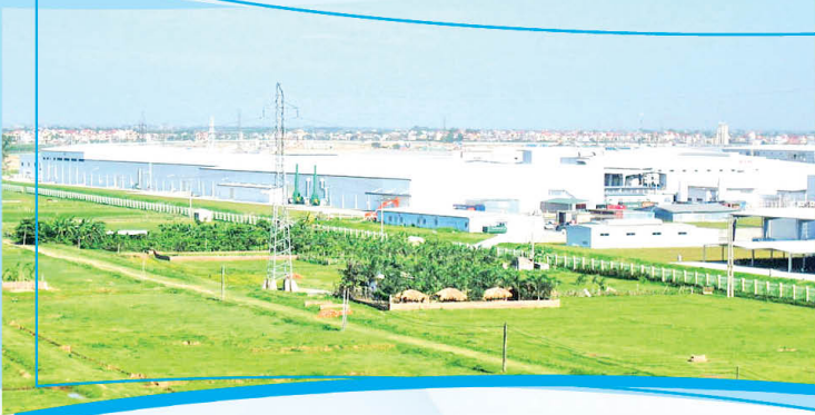
Khu công nghiệp Thuận Yên/ Thuan Yen Industrial Zone
