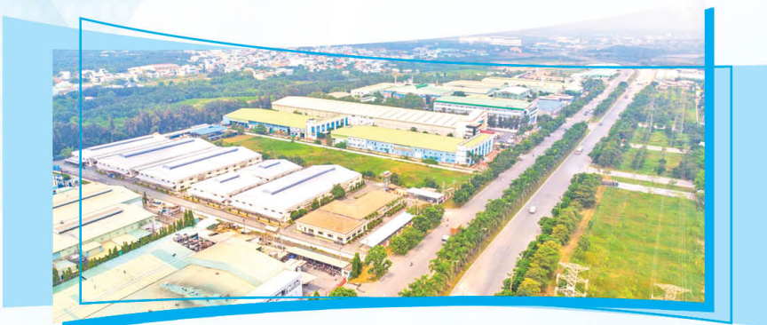
Khu công nghiệp Thạnh Lộc/ Thanh Loc Industrial Zone
