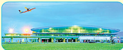
Đầu tư mở rộng nhà ga cảng hàng không quốc tế Phú Quốc, tỉnh An Giang Investment in the expansion of Phu Quoc International Airport terminal, An Giang province
