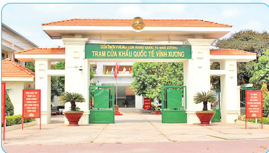
Trạm cửa khẩu quốc tế Vinh Xuông/ Vinh Xuong International Border Gate Station
